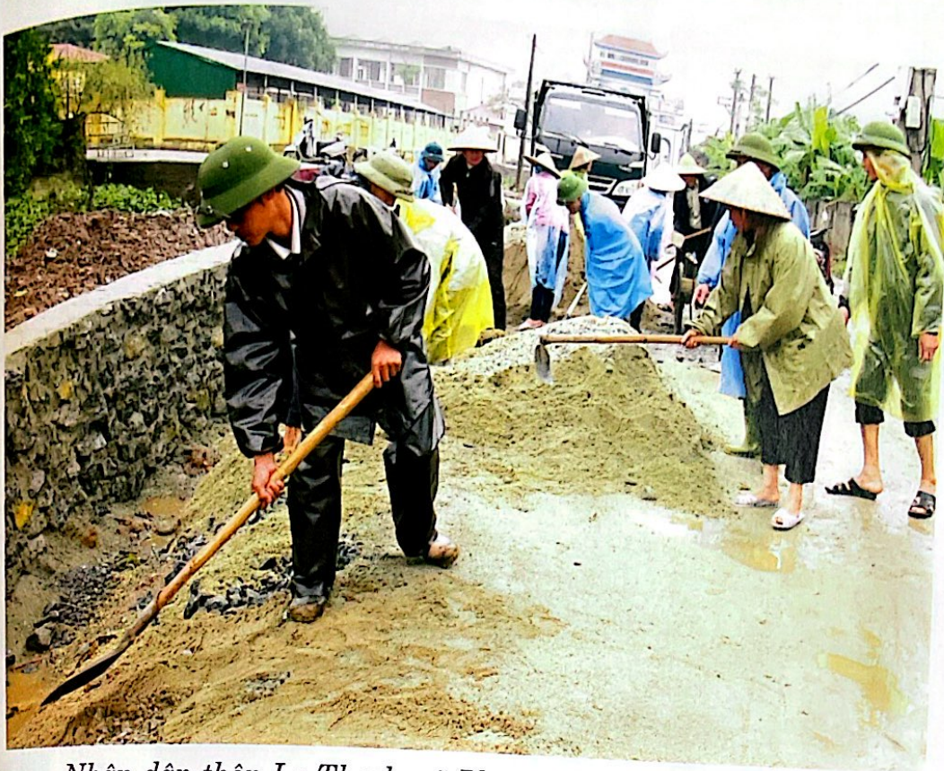
Nhân dân thôn La Thạch, xã Phương Đình thi công xây dựng đường xóm ngõ, năm 2012
