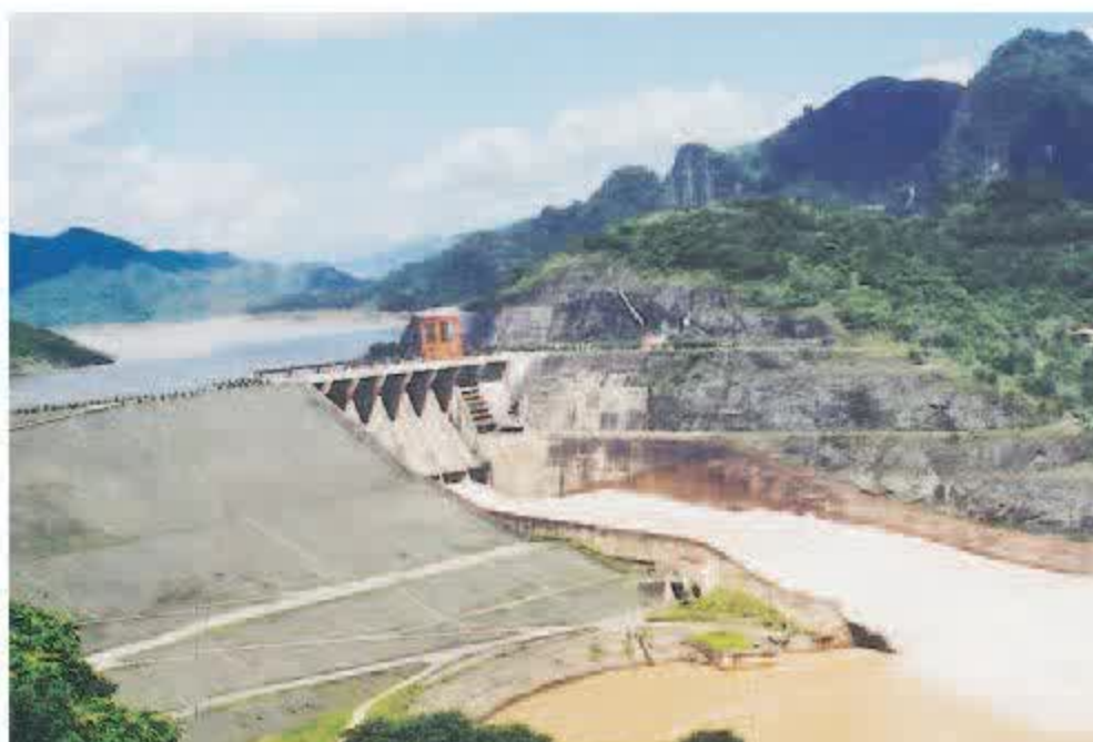
④ Nhà máy thủy điện
