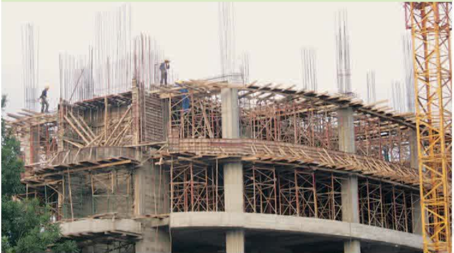
③ Đổ bê tông cốt thép
