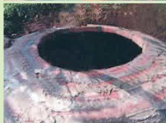
⑧ Xây hầm ga chứa phân trâu, bò, lợn,... để làm khí đốt (bi-ô-ga)
