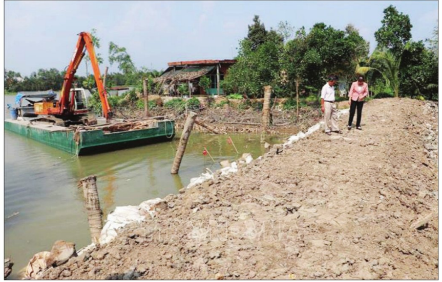
Đắp kênh Lầu tại xã Ngũ Hiệp, huyện Cai Lậy vừa được hoàn thành phục vụ ngăn mặn.
