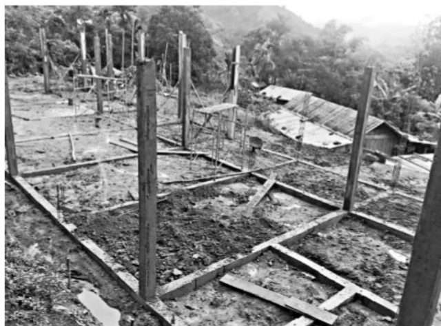
Điểm trường thôn 5 Takchai đang trong quá trình xây dựng gần bên cạnh các phòng học cũ đã xuống cấp.
