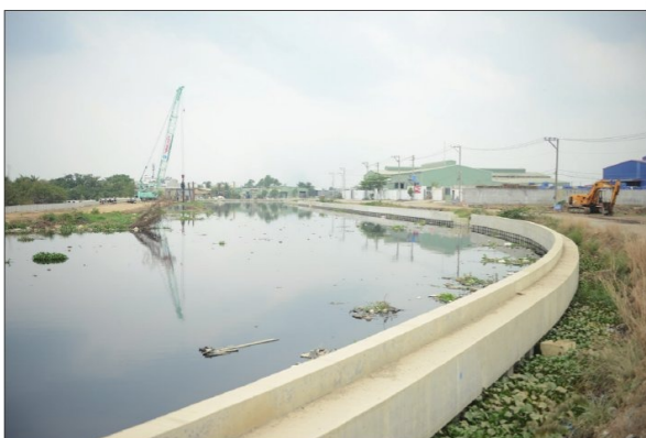
Gói thầu XL-03 đã hoàn thành 100% thi công cọc và dầm mũ.
