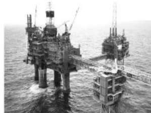
Sleipner Riser là điểm kết nối của các đường ống dẫn khí Langeled North và Langeled South nối nhà máy chế biến Nyhamna trên bờ biển phía Tây của Na Uy với kho cảng Easington ở Đông Bắc nước Anh. (Ảnh: Equinor).
