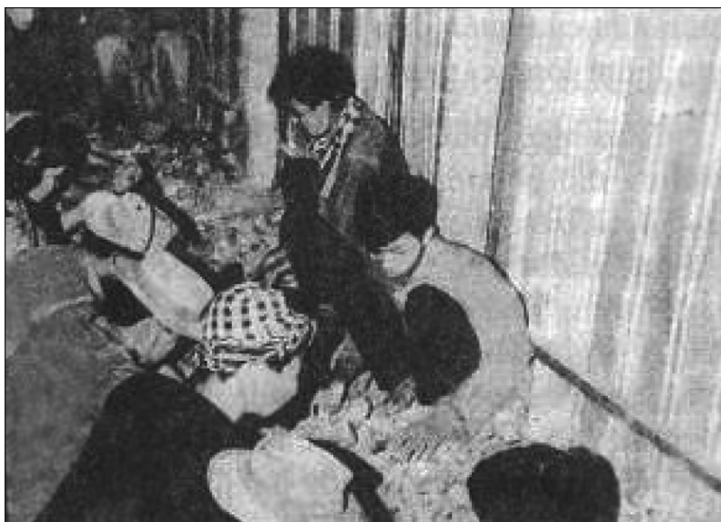
Quần dân xã Long Đức tích cực góp công xây dựng Đền thờ Bác lần thứ nhất.
