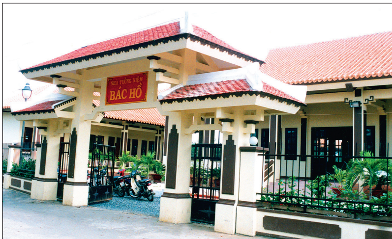
Toàn cảnh nhà tưởng niệm Chủ tịch Hồ Chí Minh tại số 28/8/, khu phố 2, phường Bình Thuận, quận 7, TP. Hồ Chí Minh, xây dựng năm 2001.
