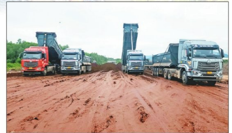
Thi công cao tốc Biên Hòa - Vũng Tàu.
