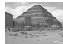
Kim tự tháp Saqqara
