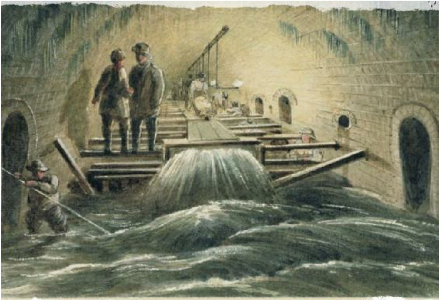
Bức họa năm 1854 cho thấy những người công nhân đang sửa chữa cống của khu phố Fleet, Luân Đôn.
