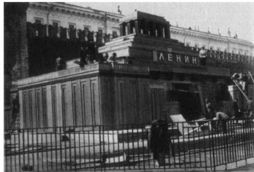
Mùa xuân năm 1924 bắt đầu tiến hành xây Lăng Lenin thứ hai (bằng gỗ). Trên ảnh: Lắp ráp các cửa mặt tiền.
