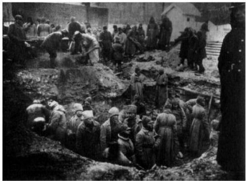
Bằng thuốc nổ, cuộc chìm và xẻng, công nhân và các chiến sĩ Hồng quân đào hố móng dưới Lăng Lenin tạm thời trên Quảng trường Đỏ.
