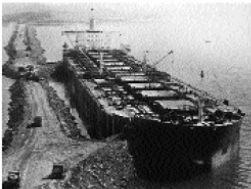
Năm 1984. Hoàn tất con đập với sự trợ giúp của chiếc tàu chở dầu.
