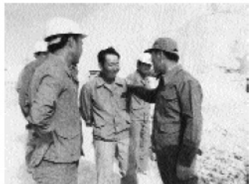
Thập niên 1970. Tại một công trường xây dựng ở Trung Đông.
