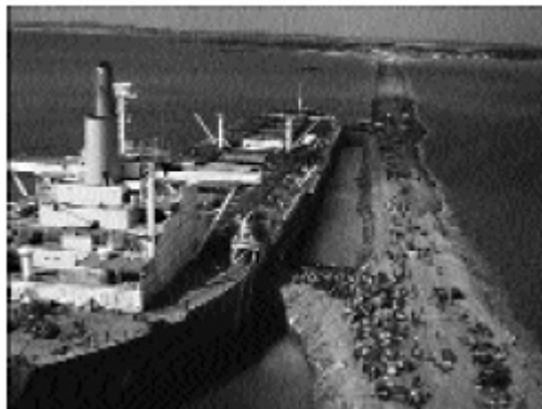
Năm 1984. Hoàn tất con đập với sự trợ giúp của chiếc tàu chở dầu.
