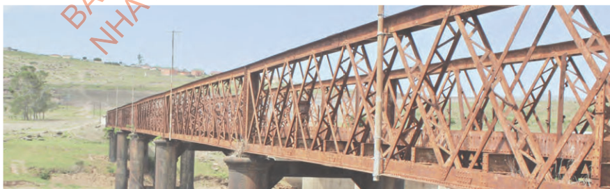
▲ Hình 11.3. Cầu sắt bị hoen gỉ theo thời gian
