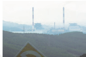
▲ Hình 10.8. Nhà máy nhiệt điện
