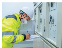
a) Vận hành hệ thống điện
