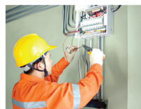
d) Lắp đặt mạng điện trong nhà
