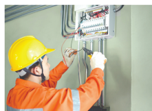
b) Thợ lắp điện cho toà nhà
