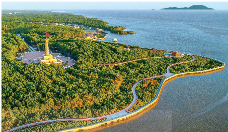
Hình 3. Kè chắn sóng, chống sạt lở ở Cà Mau
