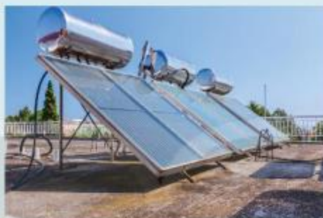
Hình 15.2 Bình nước nóng năng lượng mặt trời
