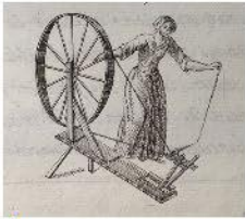
2.1 Kéo sợi bằng tay dùng một cọc sợi
