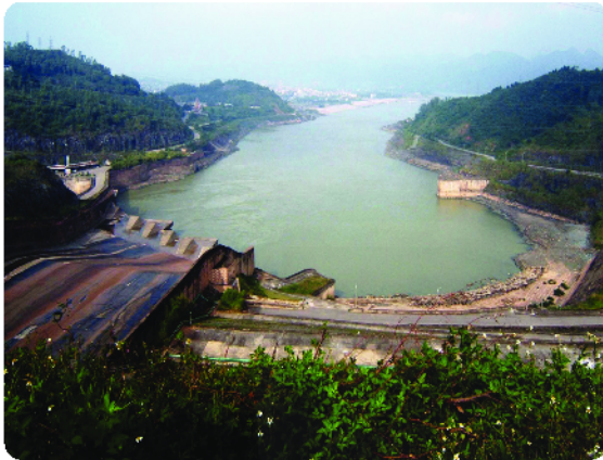
a) Đập thủy điện
