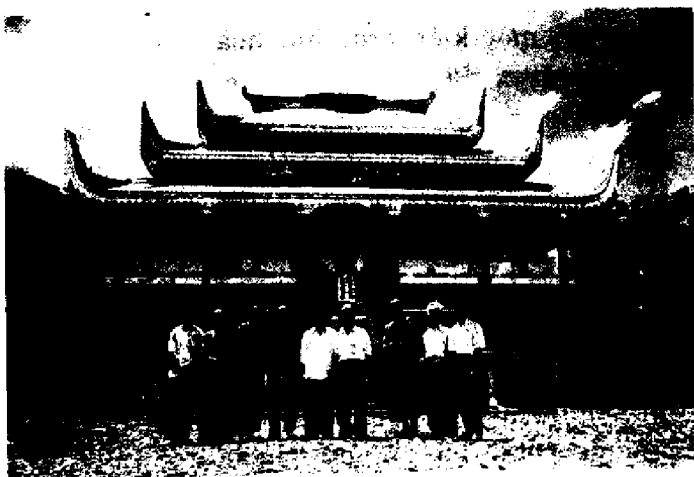
Mặt tiền Chánh Điện Linh Phú Tự
