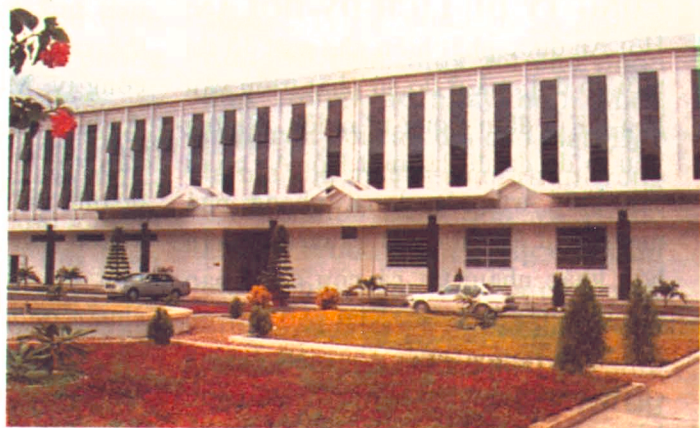
Trụ sở Công Ty Khánh Việt
