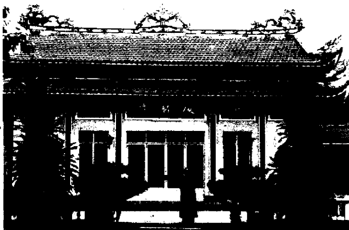
Mặt tiền Chánh Điện
