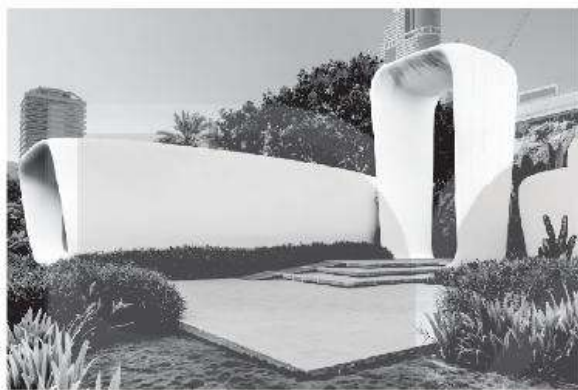
Hình 5. Một phần toà nhà ở Đu-bai được xây dựng bởi máy in 3D
