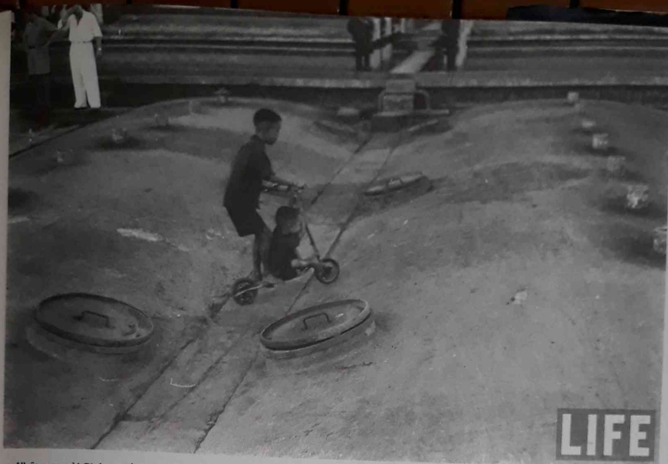
▲ Những người Pháp cuối cùng tại Nhà máy nước Yên Phụ 5
