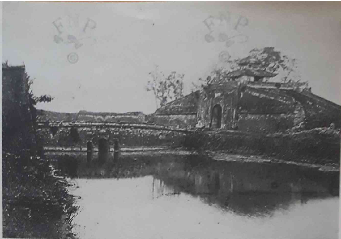
Hình 4.- Cửa Bắc của Thành chụp năm 1884. Bản kẽm của Viện Viễn Đông Bắc Cổ Pháp chụp lại ảnh do bác sĩ Hocquard chụp năm 1884, được Crémnitz xuất bản. Kích thước: 23cm x 17cm. Đại lộ Phan Đình Phùng (boulevard Carnot) nằm trên vị trí của con hào cũ đẩy nước 54 mà ta có thể thấy trên ảnh. Chiếc cửa vẫn còn nhưng vọng lâu phía trên đã bị méo mó qua chỉnh trang 55 .
