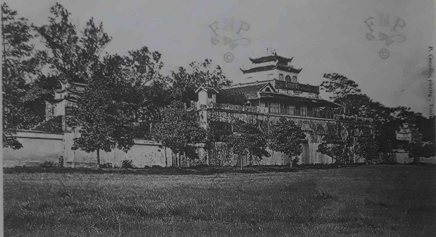
65. - TONKIN. - HANOI. - Façade Sud de la Citadelle
