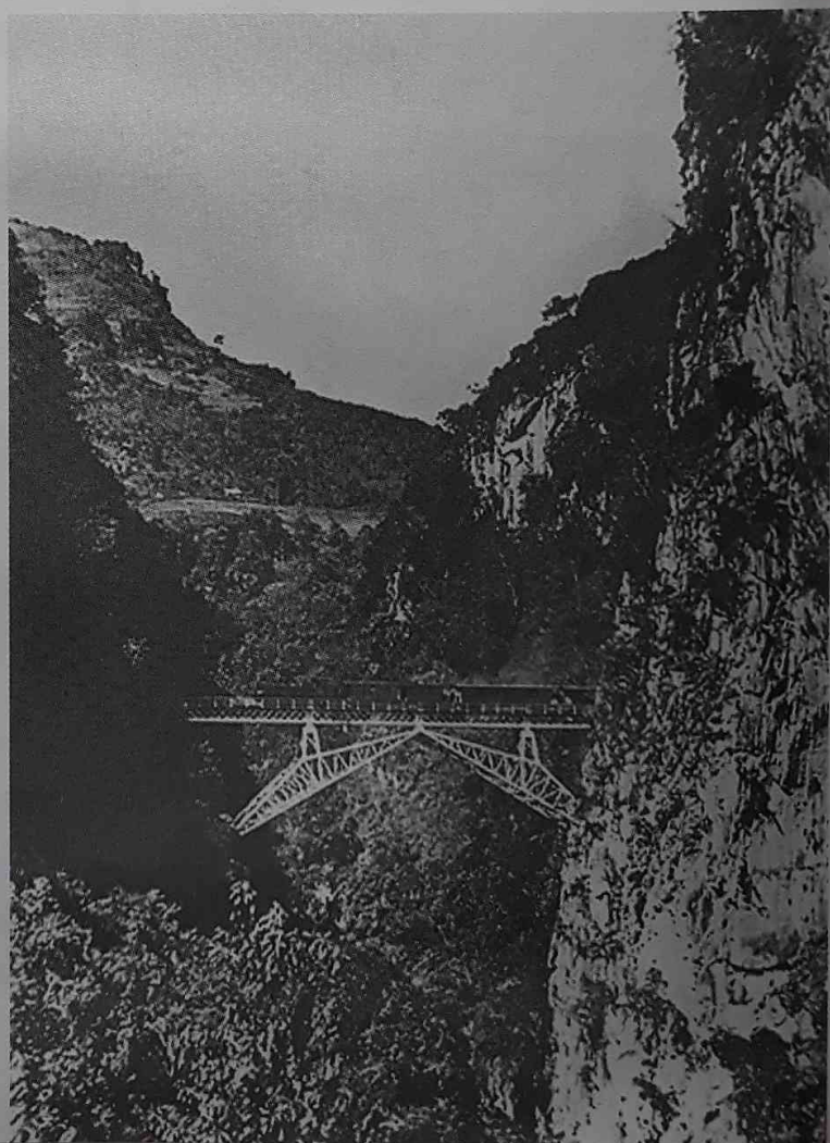
Cầu giữa hai đường hầm trên đường sắt Hà Nội – Côn Minh Nguồn: http://caom.archivesnationales.culture.gouv.fr
