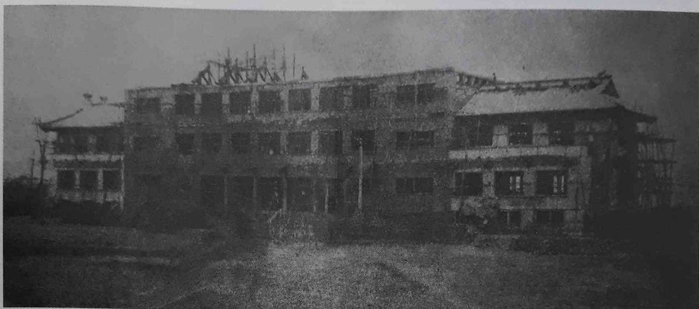
Một tòa nhà đang được xây dựng
