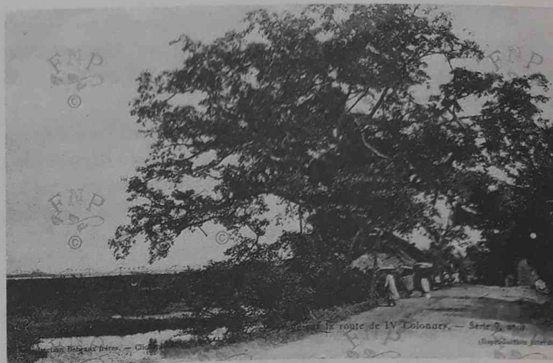
Đường Yên Phụ dẫn tới đền Tú Tru
