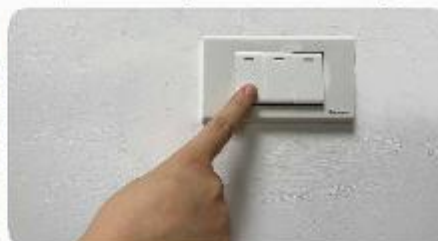
e) Tắt điện khi không sử dụng
