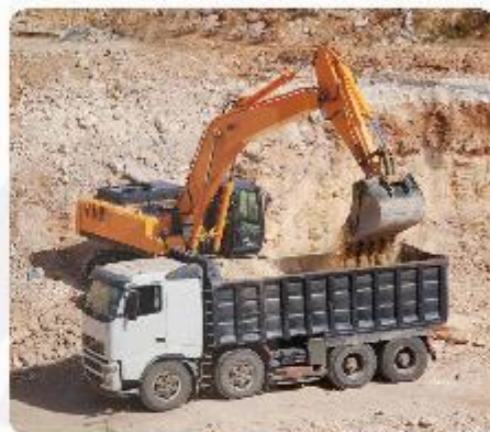
b) Máy xúc đất
