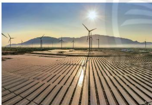
f) Trạm phát điện gió
