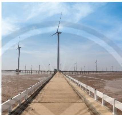
b) Trạm phát điện gió (Bạc Liêu)
