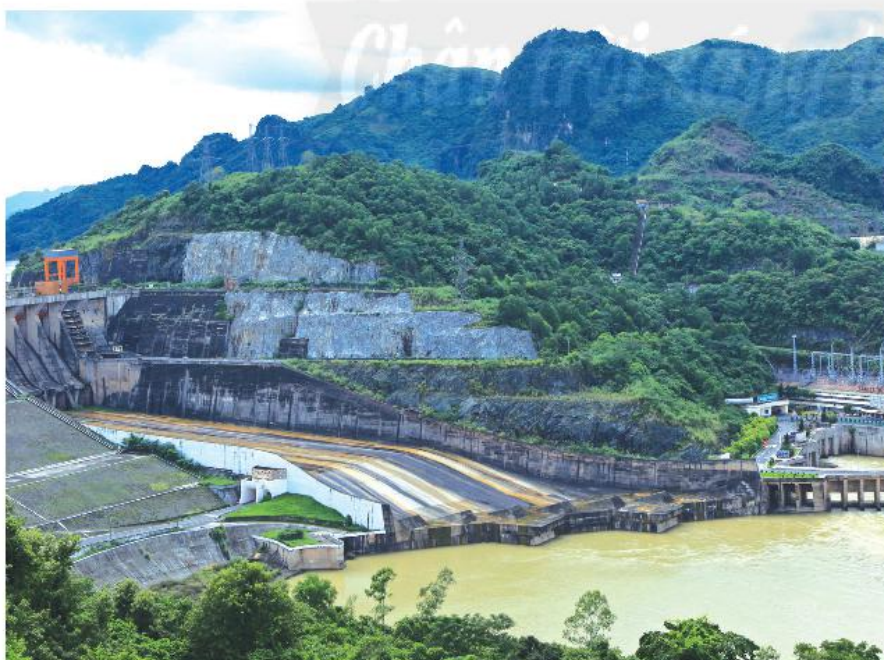
c) Nhà máy thủy điện (Hoà Bình)
