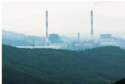
▲ Hình 10.8. Nhà máy nhiệt điện
