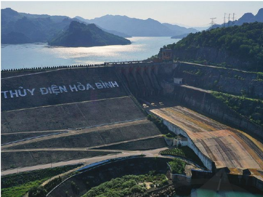
Hình 3.9. Nhà máy thủy điện Hoà Bình có hồ chứa với diện tích 208 km 2 và dung tích 9,45 tỷ mét khối nước.
