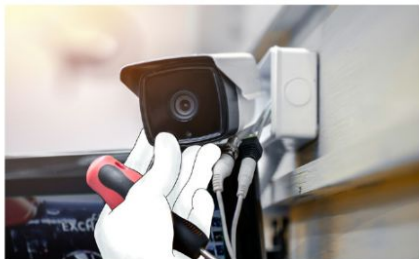
a) Lắp đặt camera
