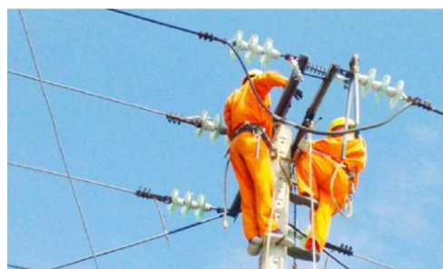
Hình 2.4. Lắp đặt điện
