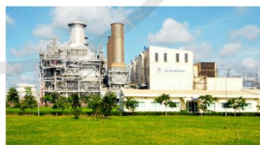
b) Nhà máy nhiệt điện
